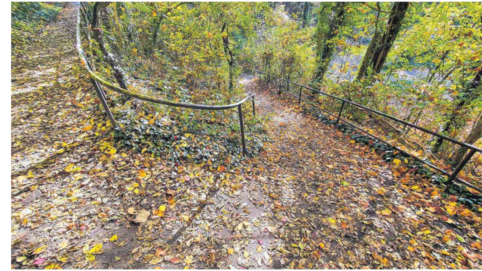
Der Weg unterhalb der Grundschule Breitenstein sieht idyllisch aus, zumal im milden Licht des Herbstes. Doch für Fahrradfahrer stellt er eine Gefahr dar.
